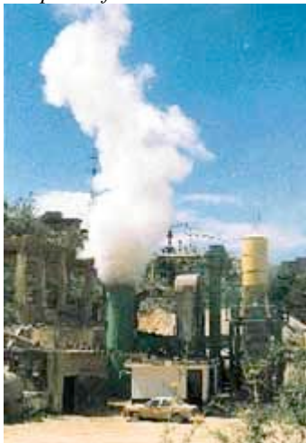
Fumées épaisses irritant des malaxeurs-asphalteuses de la région polluée de Nahr el-Moth.
