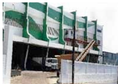
L'usine de la Quarantaine à l'entrée exigüe.
